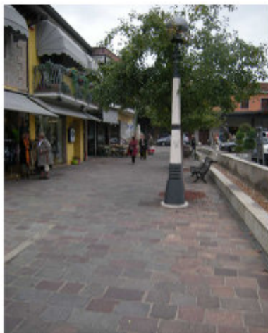
Area pedonale in lastre in porfido posate a correre
