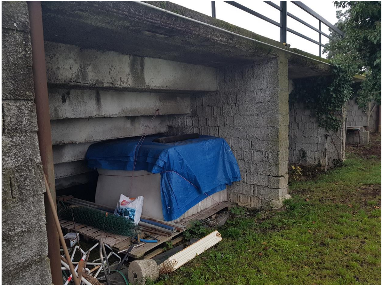
Struttura portante delle tribune esistenti a servizio del campo da calcio principale
