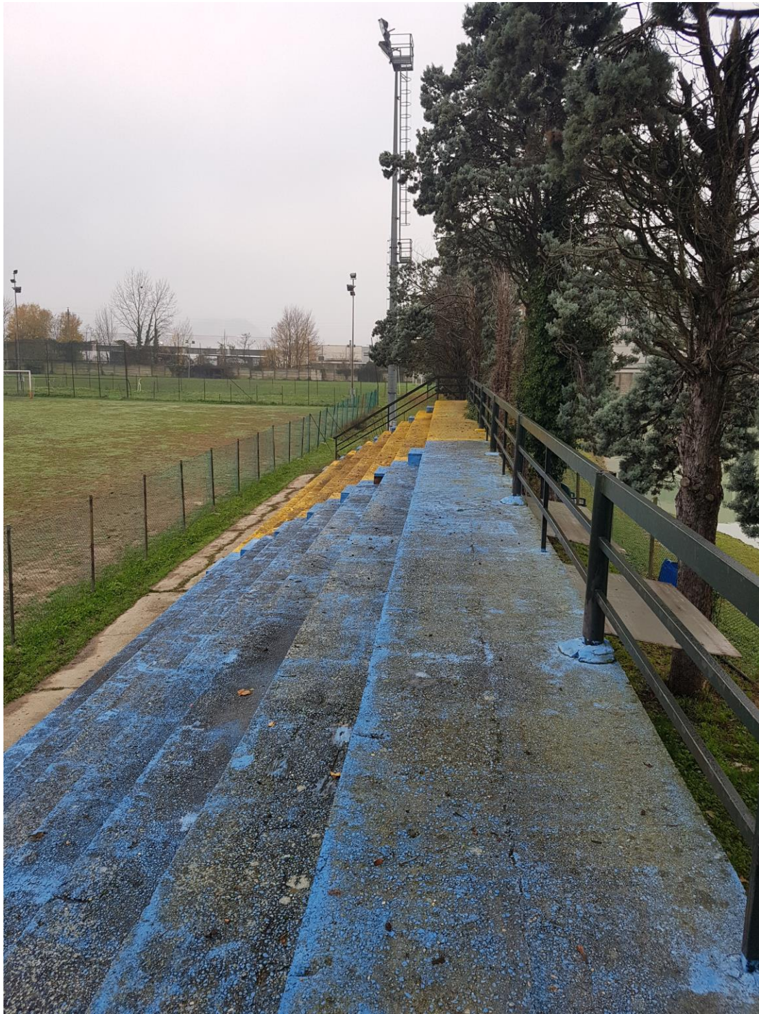
Foto delle gradinate esistenti
